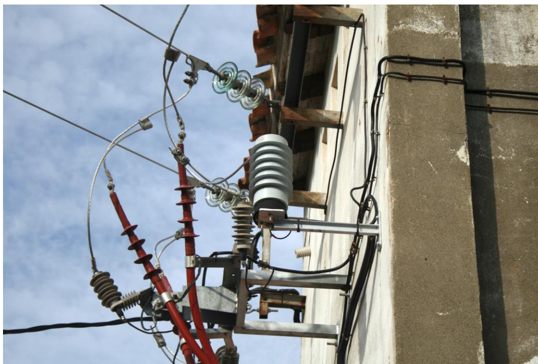
Figura 9 Ejemplo de instalación del CAMS-10/RC en línea aérea
