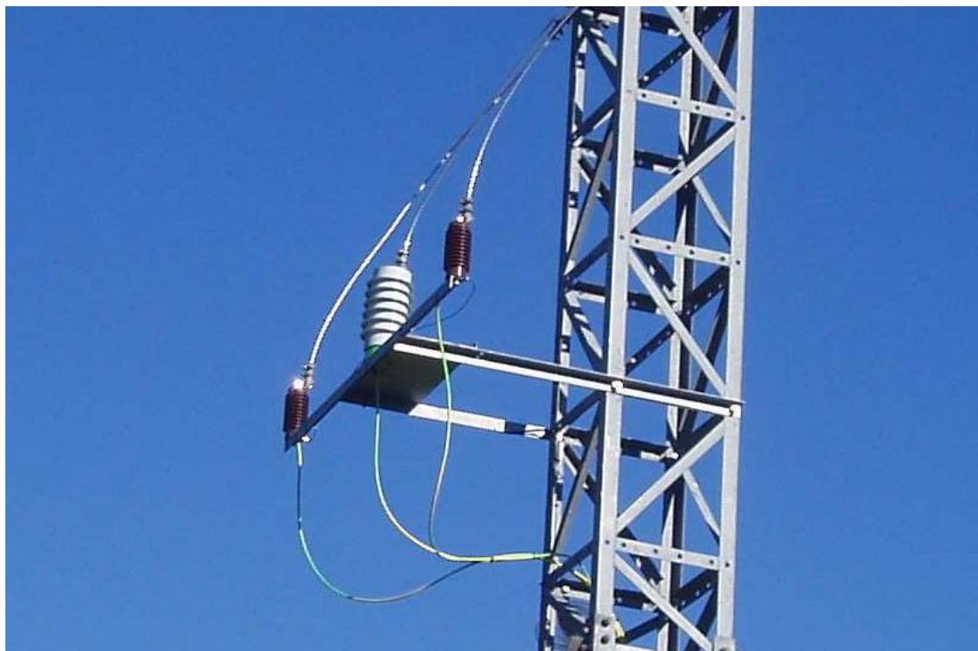
Figura 8 Ejemplo de sujeción mediante un herraje unido a la torre eléctrica
