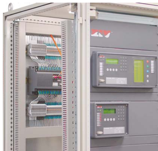
Figura 8: Unidad de posición y dos unidades locales de visualización
