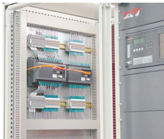
Figura 9: Dos unidades de posición compartiendo una unidad de visualización
